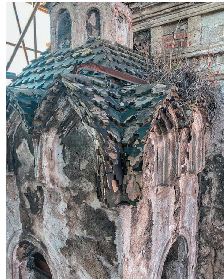
Михайловым. С помощью 3D-лазеров по материалам обмеров создавали формы моделей. После обжига сварили получившиеся цвета с первоисточником, браковали неудавшиеся образцы, добивались наилучшего соответствия колористике и облику оригинала.
